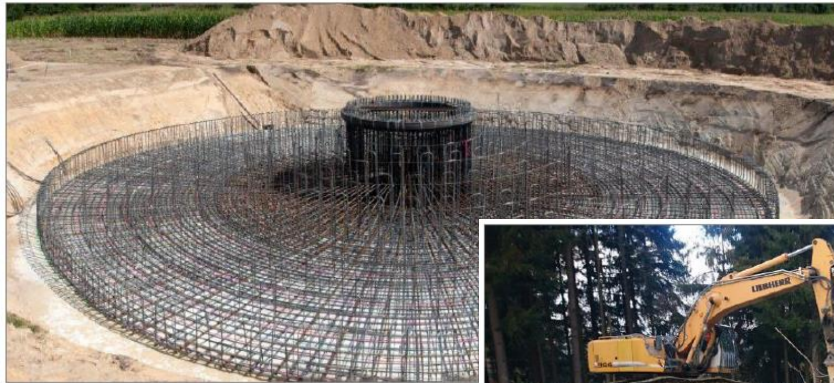
Abb. 9: Flachfundament (© F. Steinmann, LLUR)
