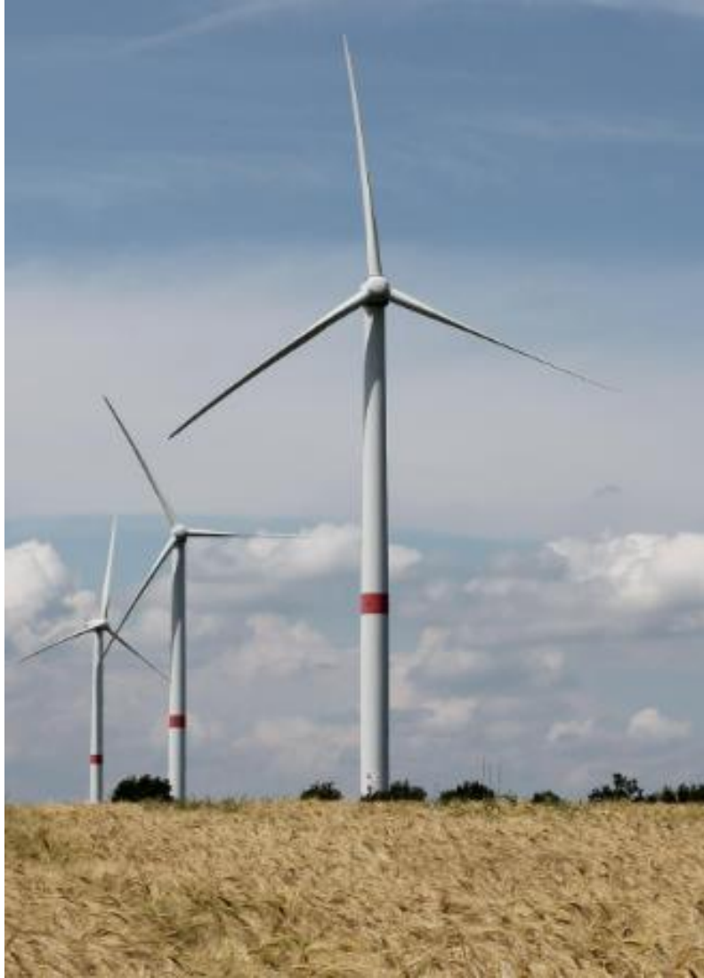
Anlage steht. Rotorblätter sind „in den Wind gedreht“. Trudelbetrieb.
