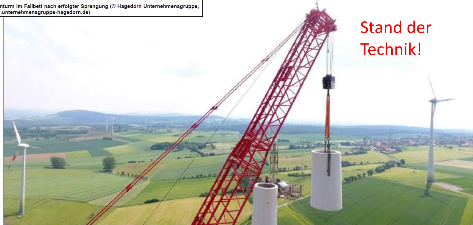
Abb. 18: Mechanischer Rückbau eines Betonturmes (© Hagedorn Unternehmensgruppe, www.unternehmensgruppe-hagedorn.de )
