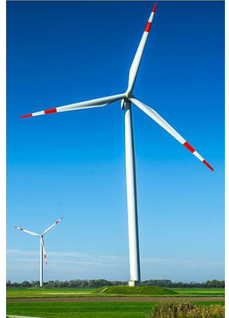
Anlage läuft. Rotorblätter fangen den Wind ein.
