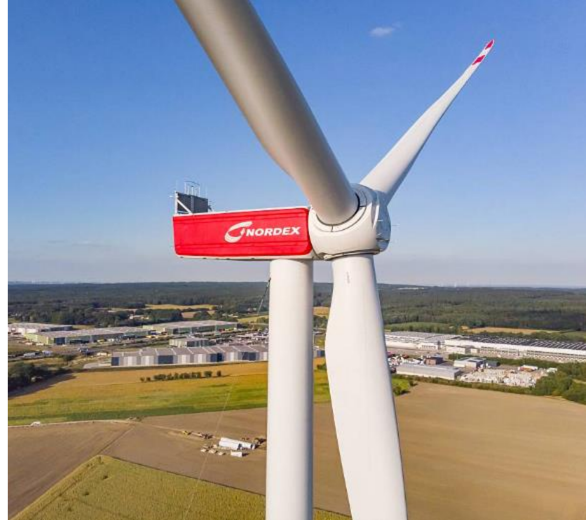
Beispiel: Nordex-WEA mit Getriebe. Nenndrehzahl: 10 Upm Billiger in Anschaffung, teurer in der Wartung.
